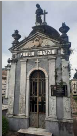
Sección 3_Solar 3_Lote 111/112 Año: S/f Constructor/Escultor: Sin datos. Placa: S. Girola
