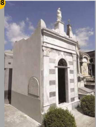
Sección 3_Solar 5_Lote 10/420 Año: 1870 Constructor/Escultor: Sin datos (restaurado)
