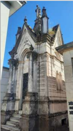
Sección 3_Solar 3_Lote 60/61 Año: S/f Constructor/Escultor: Sin datos
