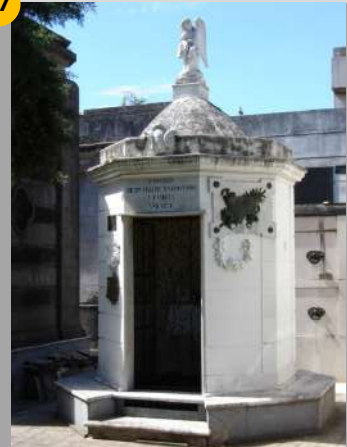
Sección 3_Solar 3_Lote 12/13 Año: 1876 Constructor/Escultor: Sin datos. Placa: M. Vanzo
